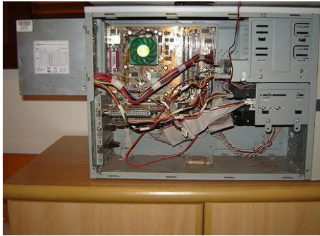
Figura 4.1: Gabinete de 3 baias com fonte dificultando refrigeração.
