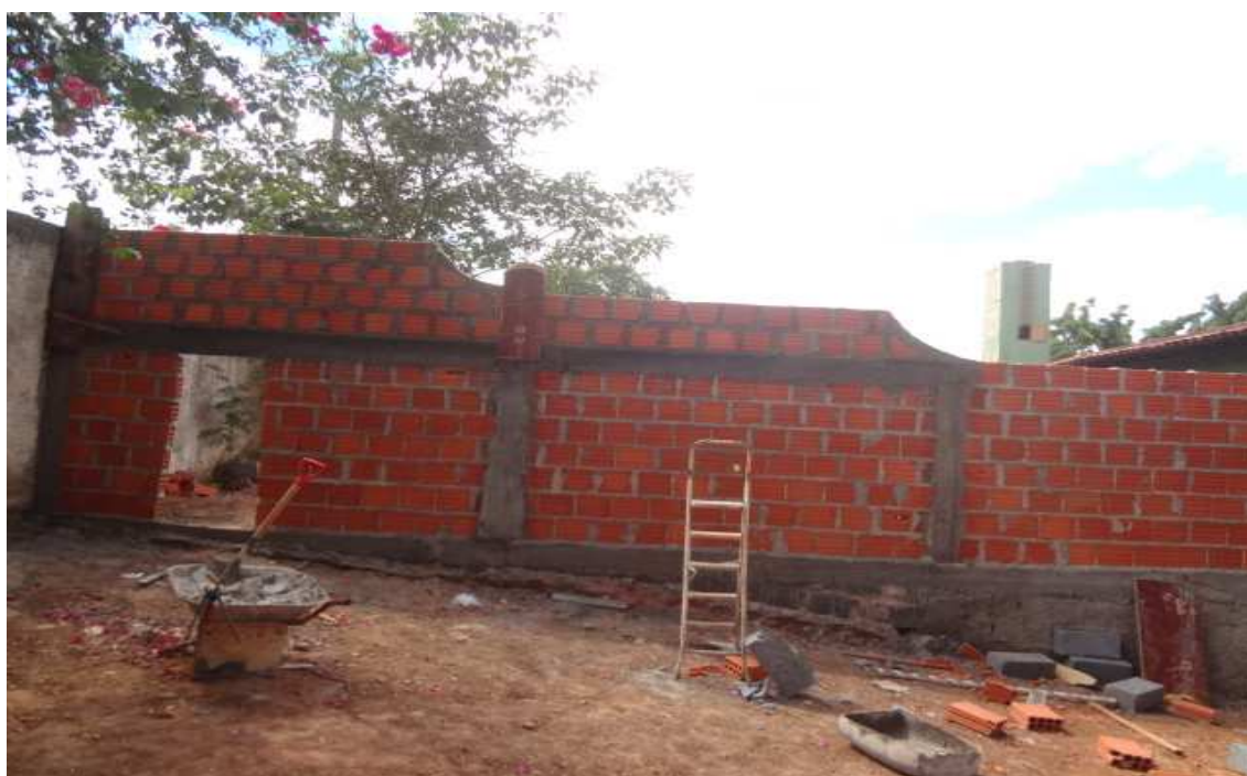
Figura 14: Ampliação da Área do Estacionamento FONTE: Arquivo da Escola
