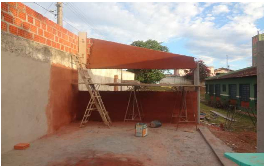
Figura 15: Construção de Galpão para Oficina na Área do Fundo FONTE: Arquivo da Escola
