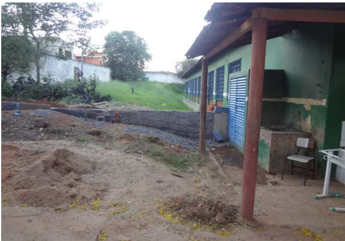
Figura 13: Reforma da área do escóvodoro e Tanque FONTE: Arquivo da Escola
