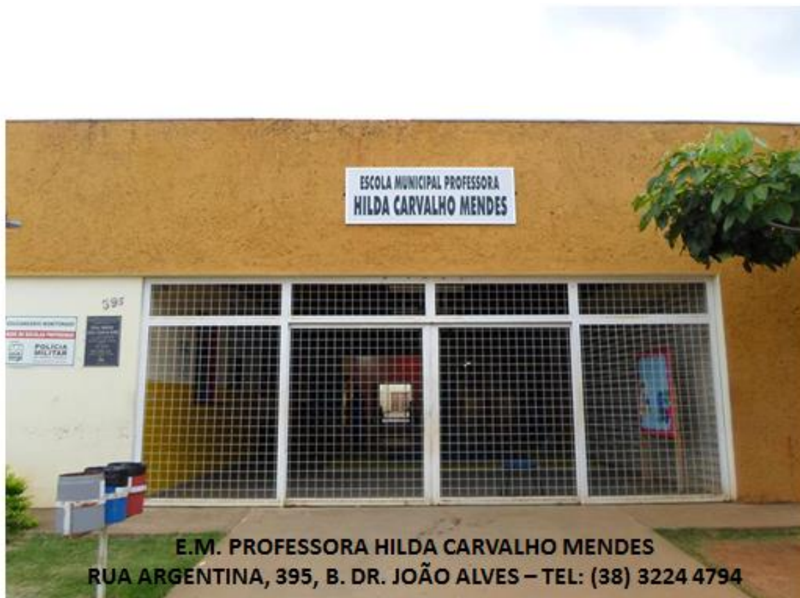
Figura 01: Vista frontal da escola
